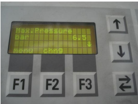
รูปที่ 4.9 การปรับลดค่าความดัน Cut in – Cut off ที่ชุดควบคุมระบบอัดอากาศ
