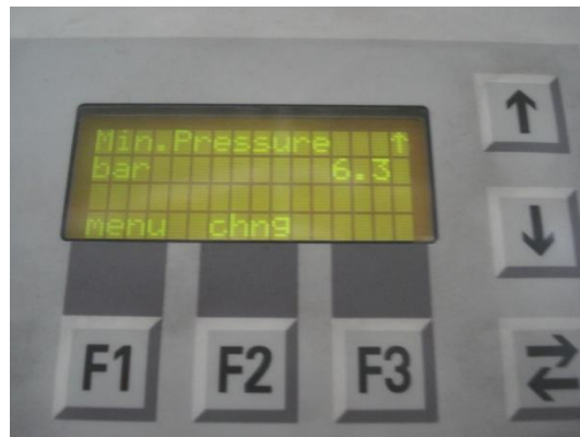
รูปที่ 4.9 การปรับลดค่าความดัน Cut in – Cut off ที่ชุดควบคุมระบบอัดอากาศ
