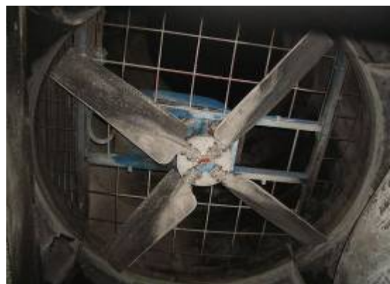
รูปที่ 1 ภาพแสดงตัว Cooling tower และใบพัดอลูมิเนียมแบบเดิมที่ใช้
