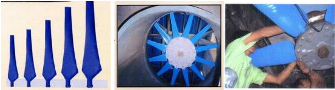
รูปที่ 2 ภาพแสดงใบพัด FRP และการติดตั้ง FRP fan ที่ตัว cooling tower
